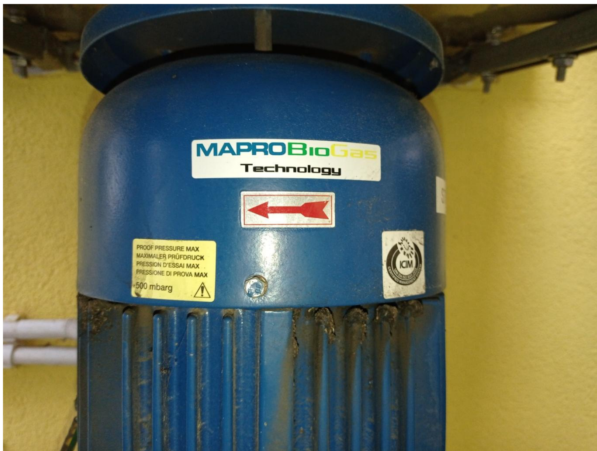
Zdjęcie 1 Istniejąca dmuchawa na Oczyszczalni Ścieków Łyna
